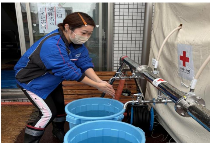
給水設備 を使用する利用者
